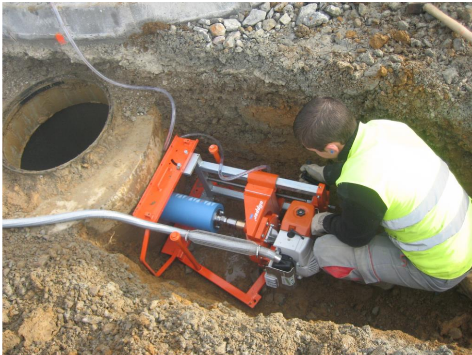
Carottage du regard existant ou créé
