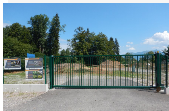
Plateforme de déchets verts du Mont-Saxonnex
