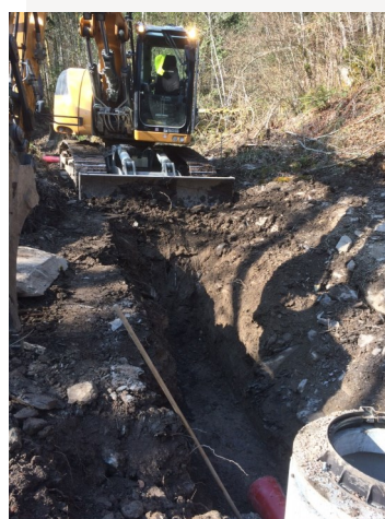
Travaux de création d'un réseau d'assainissement collectif
