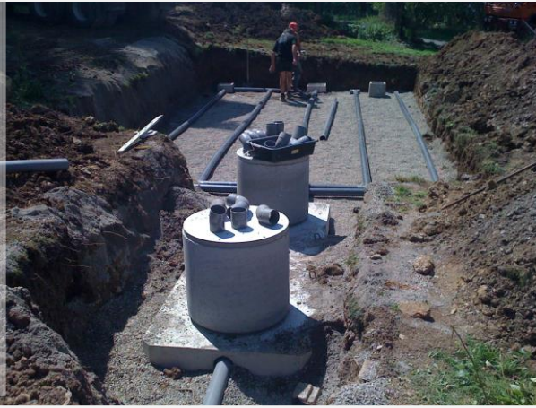
Figures 8 et 9 : exemples de rejet non-conforme et d'une installation aux normes
