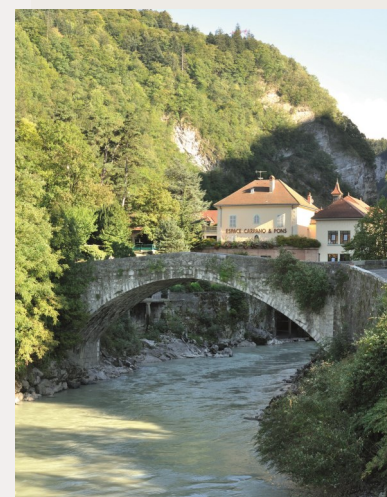
Espace Carpano Crédit photo C. Savouret
