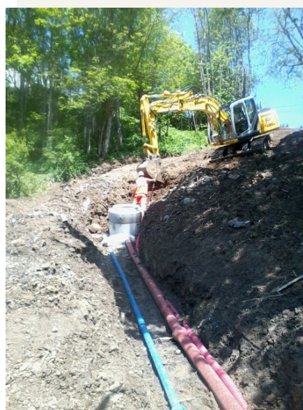
Travaux d'extension des réseaux, secteur La Combe à Arâches-la-Frasse
