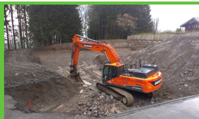
Travaux de terrassement de la nouvelle déchèterie
