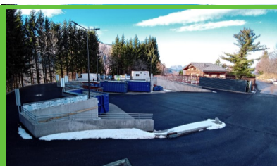
Fin des travaux de réhabilitation de la déchèterie
