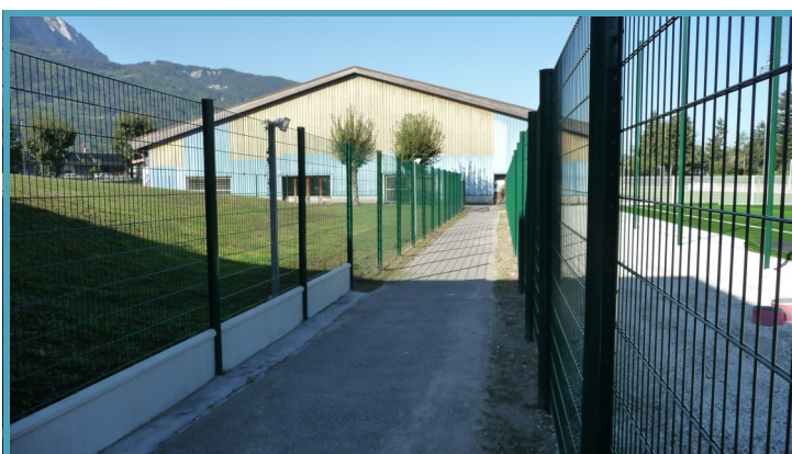
Aménagement de l'accès suite à l'arrachage de la haie
