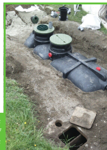
Exemples d'installations d'assainissement non collectif chez des particuliers
