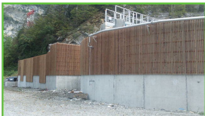
Création d'une station d'épuration à Magland
