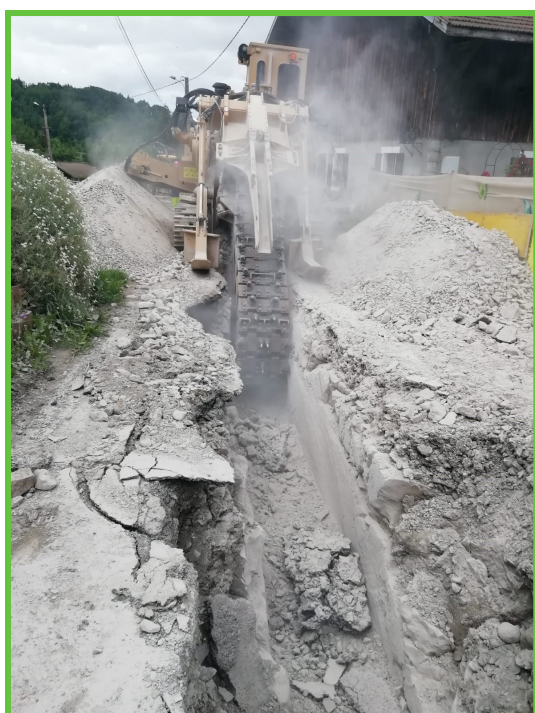
Création d'une tranchée à Nancy-sur-Cluses pour installer un réseau d'assainissement
