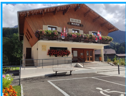
La rampe d'accès aux personnes à mobilité réduite à la mairie du Reposoir a été instruite par le service
