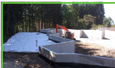
Construction des murs de soutènement et remblai
