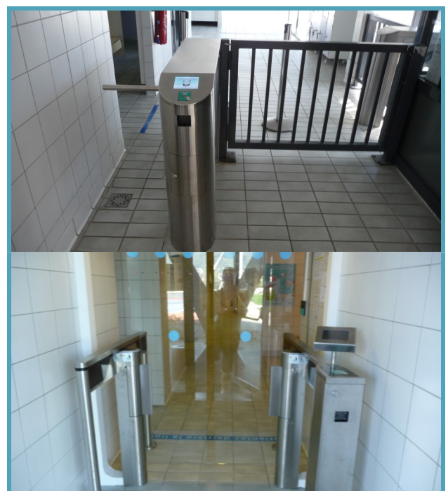
Installation d'un nouveau système de contrôle d'accès et d'un lecteur de tickets
