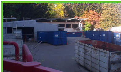
Déchèterie d'Arâches-la-Frasse avant les travaux
