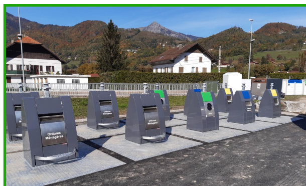
Installation de conteneurs enterrés à la place de conteneurs aériens
