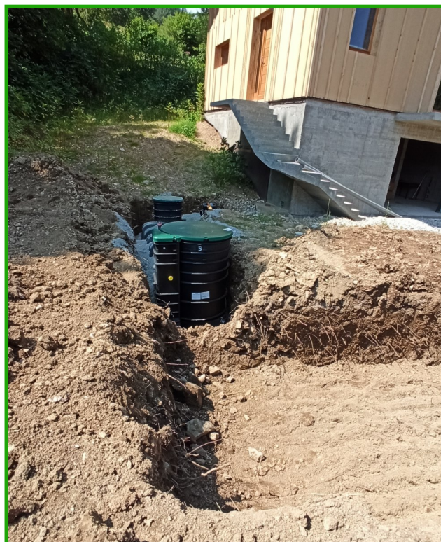
Installation d'une fosse autonome d'assainissement non collectif
