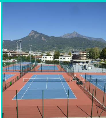
Rénovation des courts de tennis extérieurs et création d'un padel
