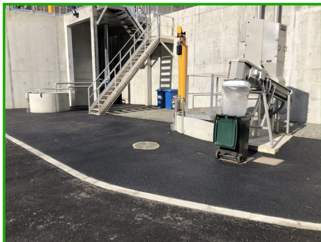
Retraitement des déchets incinérables rejetés par la nouvelle STEP de Magland
