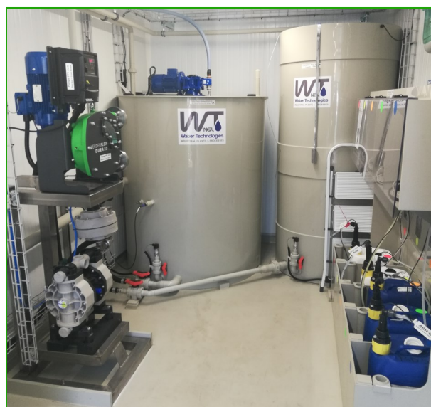
Mise en place d'une micro station d'épuration au sein d'une entreprise
