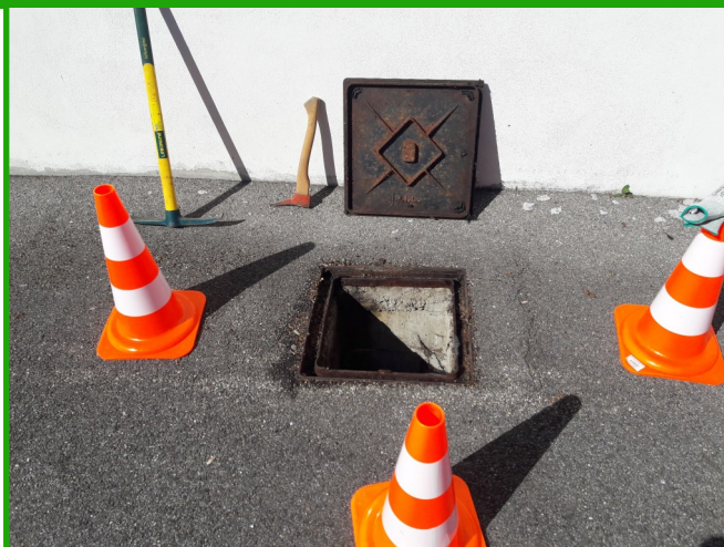
Intervention du service Assainissement sur le réseau d'eaux usées
