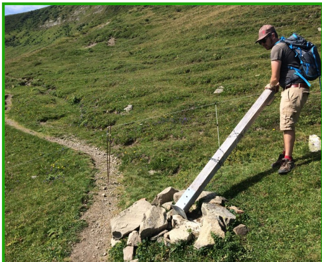
Installation d'un panneau de balisage sur la commune du Reposoir
